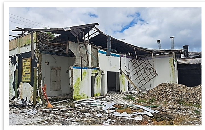
Fotografía, aspecto de demolición interior, Casa Castro (2025), BIC -Mupal
