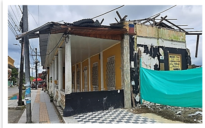
Fotografía, aspecto de demolición de Casa Castro (2025), BIC -Mupal
