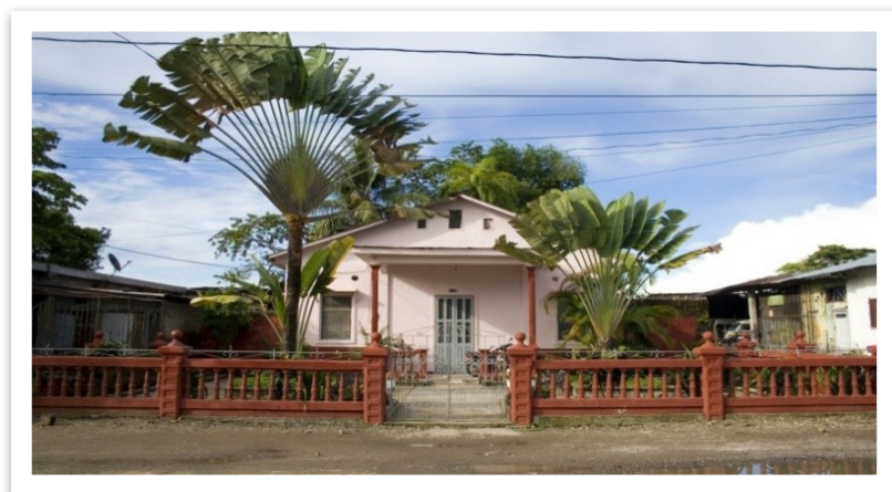
Fotografía 137. Casa Garcés: arquitectura caribeña de madera. Calle 31 – Foto donada por Najle Silva Arana.
